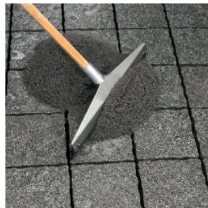
Introduire PCI Pavifix® 1K Extra dans les joints à l'aide d'une raclette en caoutchouc.
