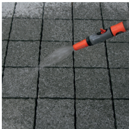
Humidifier abondamment la surface de la pierre et les flancs des joints avant le jointoiment.
