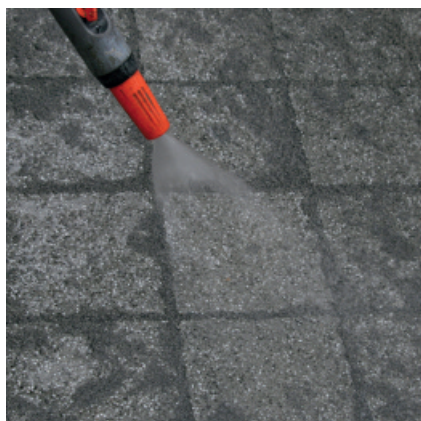
Pour les joints de 3 à 8 mm, accompagner l'introduction dans les joints à l'aide d'un jet d'eau sans pression. Faire passer le jet d'eau le long des joints. Remplir immédiatement de matériau frais.
